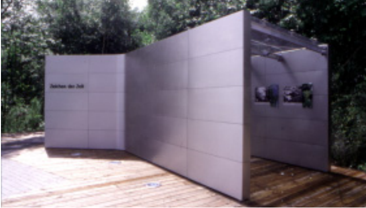
Utställningspaviljongen i 'Meteorit'-museets park i Essen är klädd med relief-mönstrad rostfri plåt.
